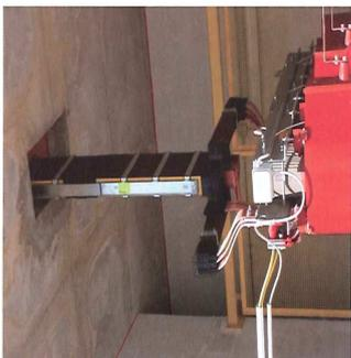
Tali quadri sono certificati dai principali costruttori fino a correnti nominali di 5000A e  $I_{cc}$  di 100 kA e vengono attualmente utilizzati nel settore industriale.
